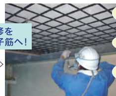
FRP格子筋の施工
